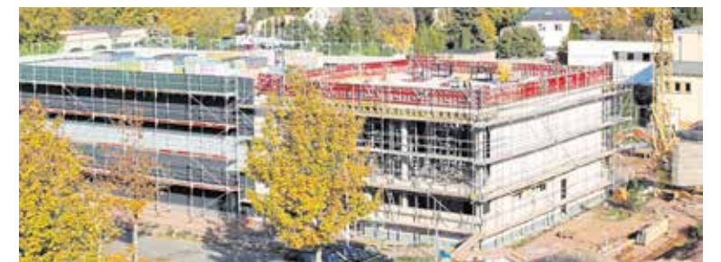
Der Rohbau mit inzwischen geschlossener Dachkonstruktion. Bis zum Frühjahr 2023 soll die Halle fertig sein.
